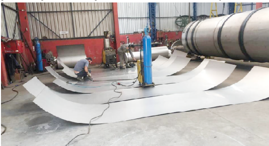
Os serviços de confecção do tanque estão sendo realizados: conquista importante
