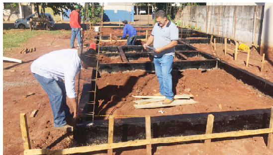
As obras de construção do vestiário seguem a todo vapor: melhorias no setor de esportes do município
