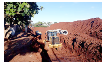
As obras serão reiniciadas na semana que vem
