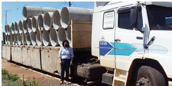
Tubos serão usados na implantação de galerias pluviais
