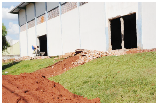
As obras seguem em ritmo acelerado: reforma importante para o esporte
