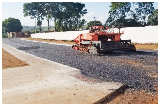
Os serviços foram realizados em toda a área interna do cemitério
