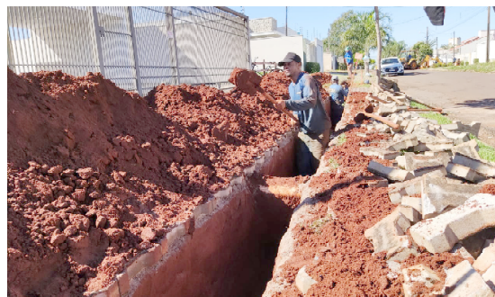
As obras estão sendo realizada no Jardim Morumbi: saneamento
