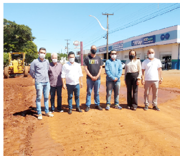
O prefeito Betinho com os vereadores durante vistoria às obras
