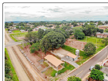
Vista aérea do parque urbano em construção
