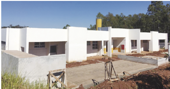
As obras da creche estão paradas desde a administração anterior: prefeitura vai retomar serviços para conclusão
