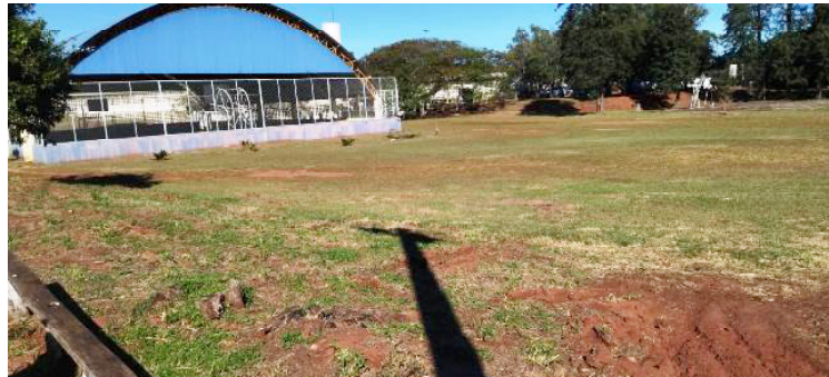
A limpeza do terreno foi feita nesta semana: apoio da prefeitura foi fundamental
