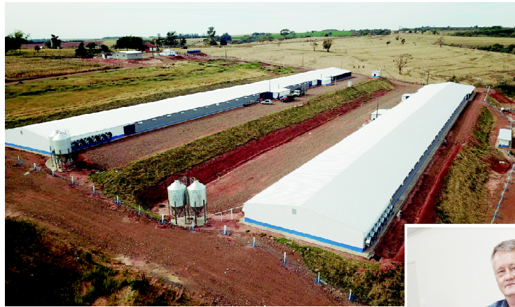
os primeiros barracões foram implantados e já estão em funcionamento
