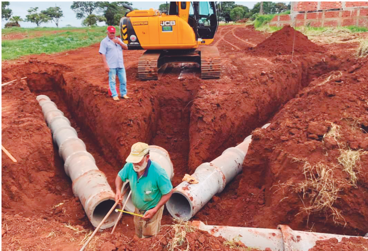
Máquinas e operários trabalham na implantação das galerias: asfalto vem na próxima etapa
