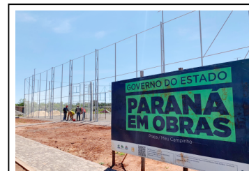
As obras seguem em ritmo acelerado: mais lazer para a comunidade
