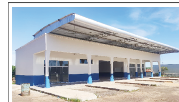
As obras já estão quase prontas: melhorias para toda a comunidade
