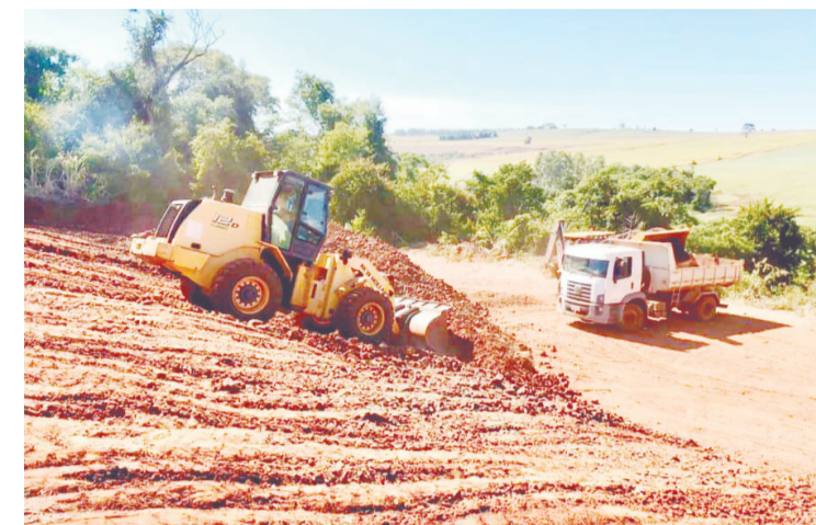
Maquinários da prefeitura trabalham na realização das obras
