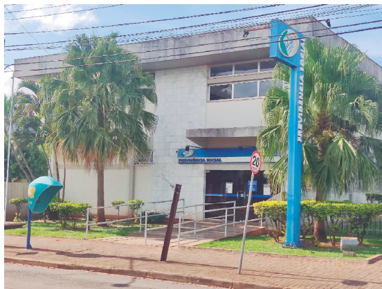
O prédio da agência do INSS de Goioerê está fechada há cerca de dois anos
