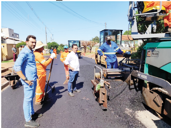
O prefeito Betinho Lima acompanhou o início das obras
