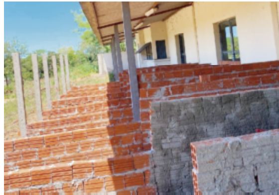
O abrigo está sendo construído com recursos municipais
