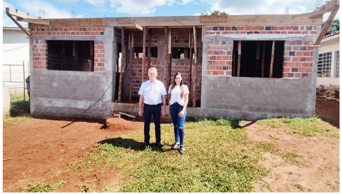
A obra está sendo custeada com recursos próprios da prefeitura Suziane Faquim. “Estamos investindo recursos próprios que economizamos ao longo do último ano para atender essa demanda”, lembra o prefeito Ismael. O refeitório conta com cozinha, uma sala para armazenar os alimentos e banheiro para os funcionários. A obra total tem 102,50 metro quadrados.
