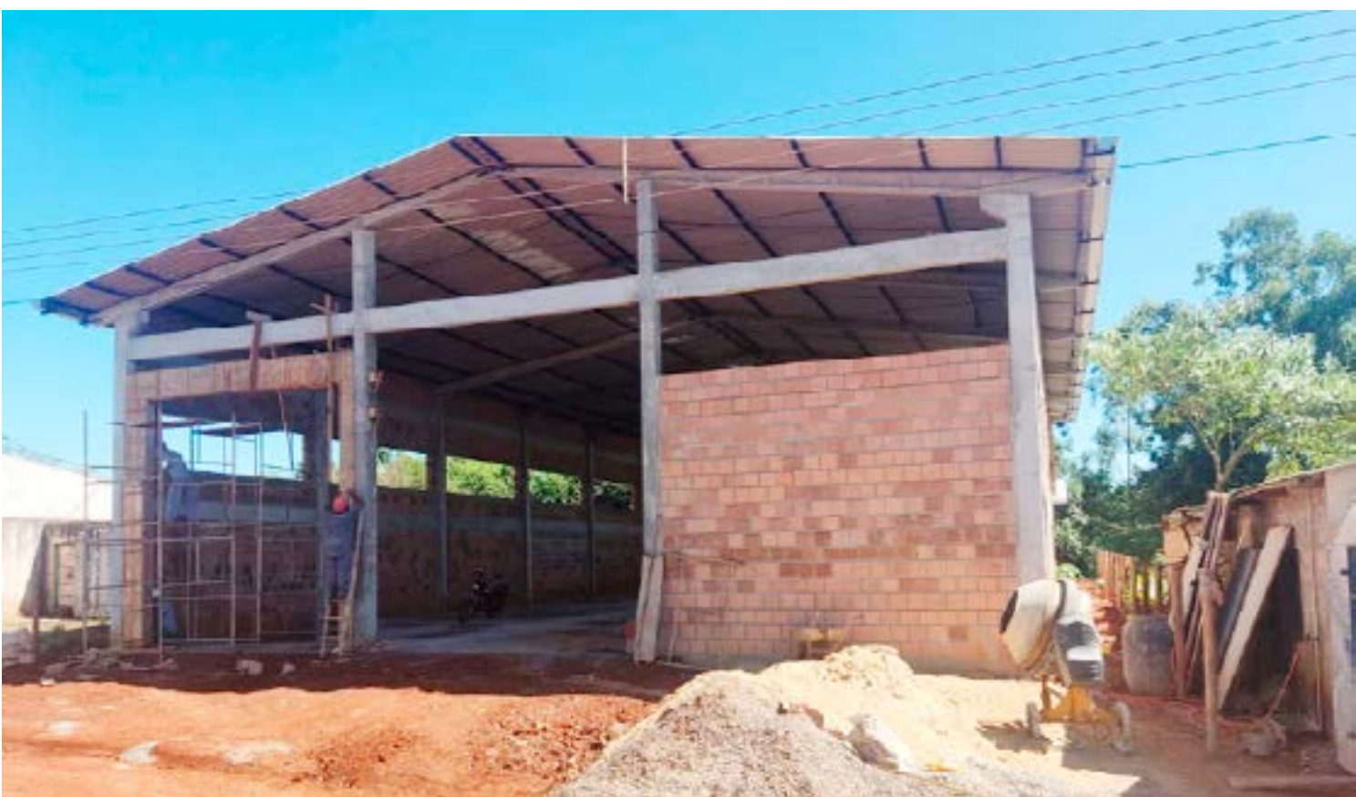
As obras do barracão estão bem adiantadas e serão entregues em breve
