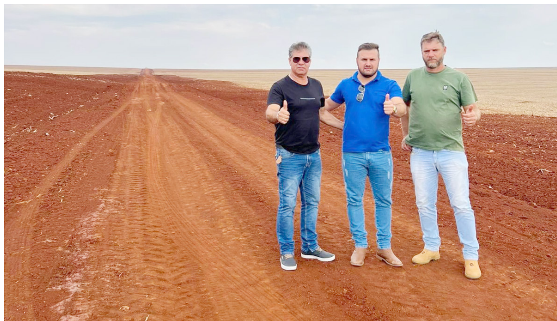
As estradas rurais do município estão sendo recuperadas por completo
