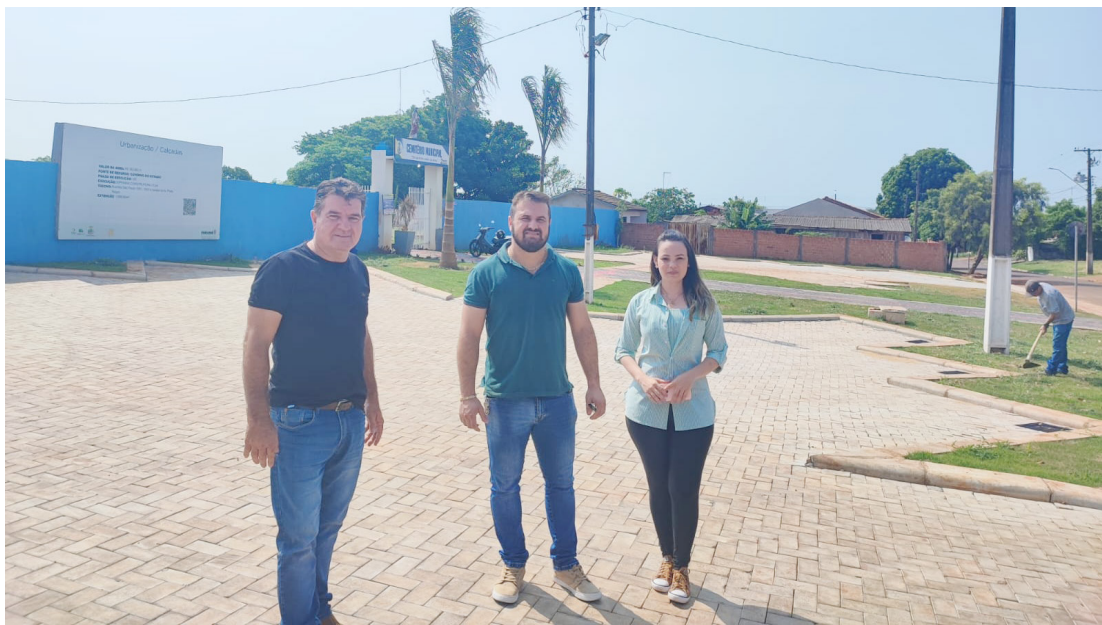
A entrega do estádio e cemitério foi totalmente revitalizada: obra foi vistoriada pelo prefeito Cássio, o vereador José Antonio e a engenheira Giliane.
