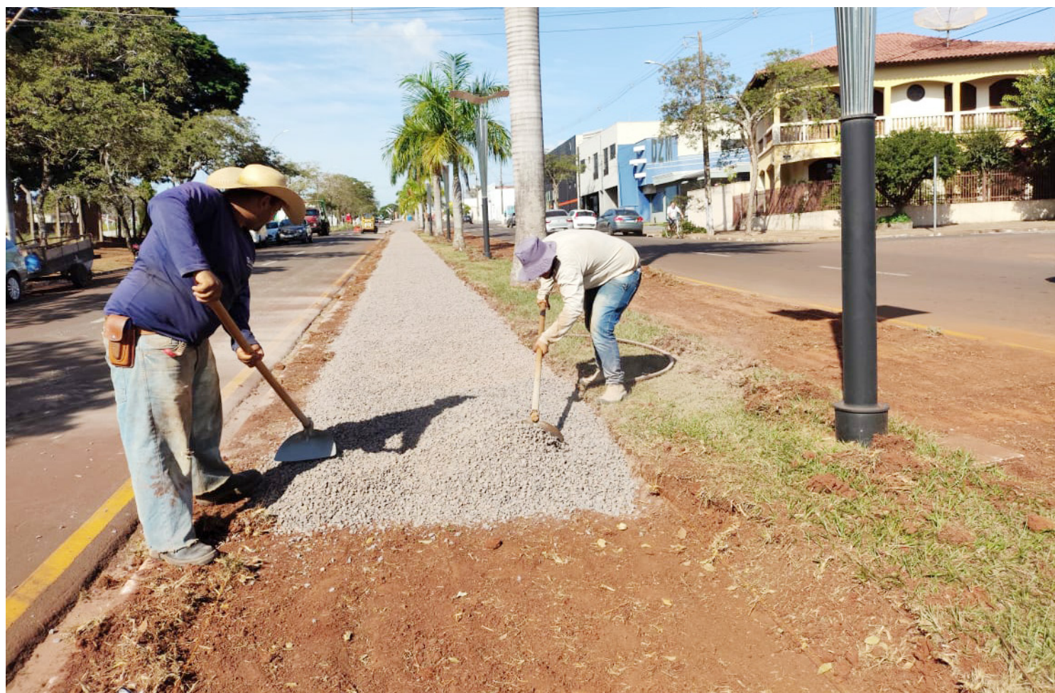
As obras estão bem avançadas: pista de caminhada e ciclovia
