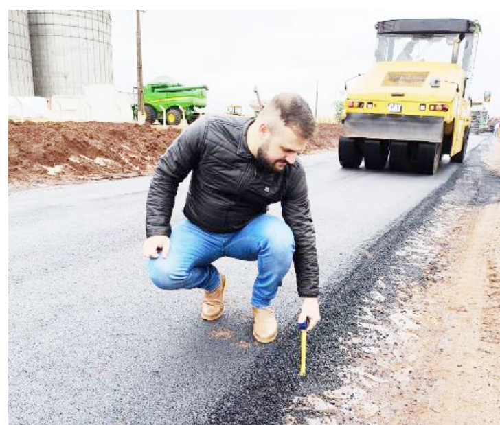
O prefeito Cássio verifica a espessura do asfalto que está sendo implantado nas estradas rurais
