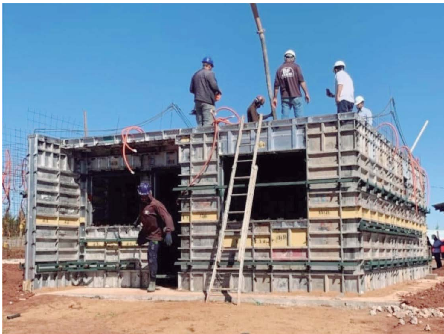
A primeira casa que teve as paredes concretadas na última terça-feira: obras avançam
