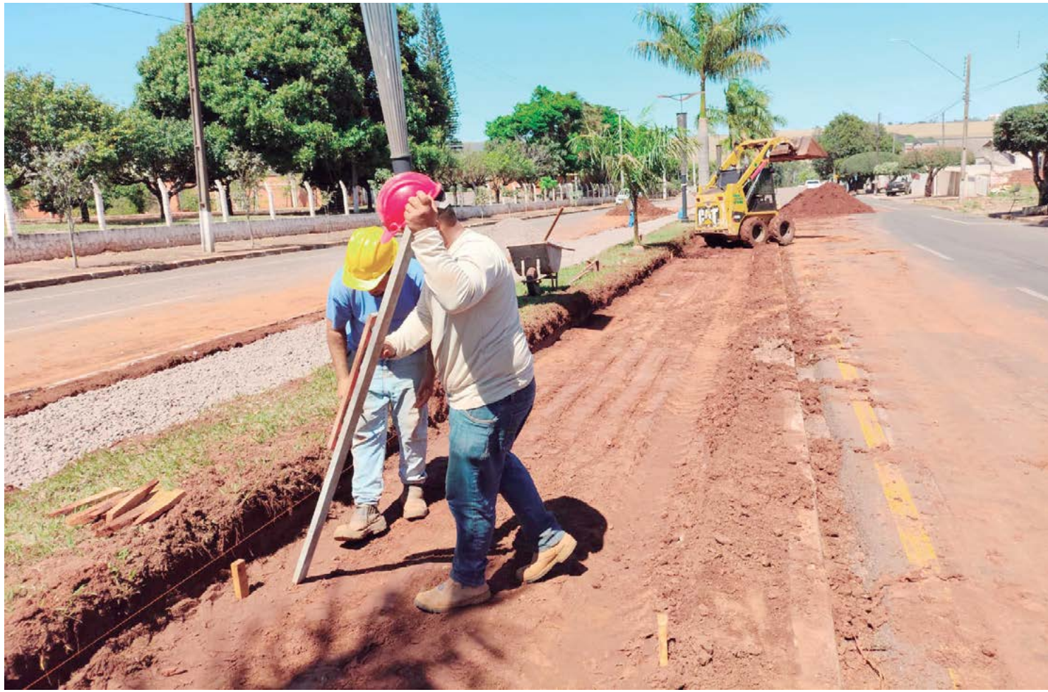
As obras na Avenida Mauro Mori estão adiantadas: ciclovia e pista de caminhada
