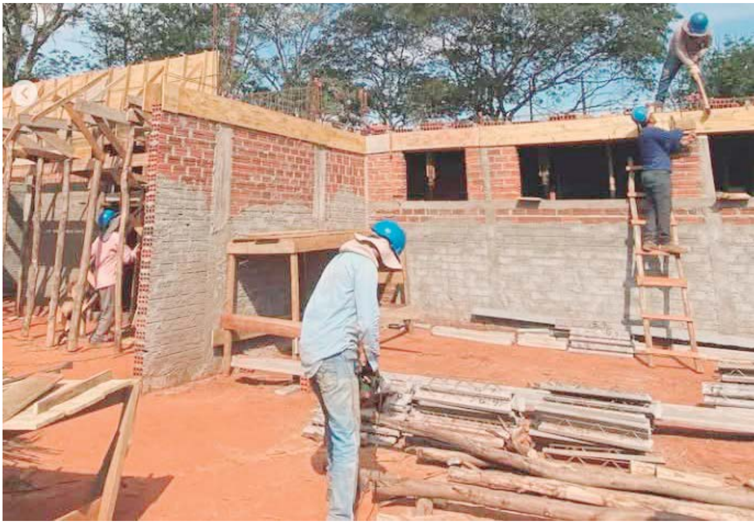
As obras estão bem adiantadas: investimentos de R$ 1,2 milhão
