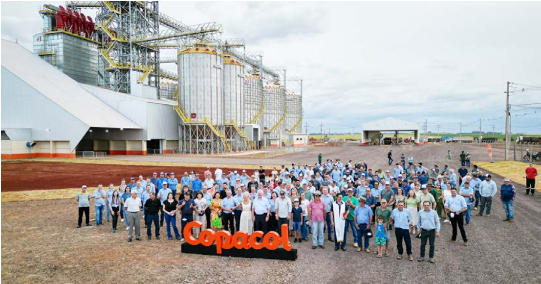
A estrutura com 13,8 mil metros quadrados construídos possui ampla capacidade de armazenagem, depósito de insumos e escritório para atendimento, no conceito Coopera Sempre
