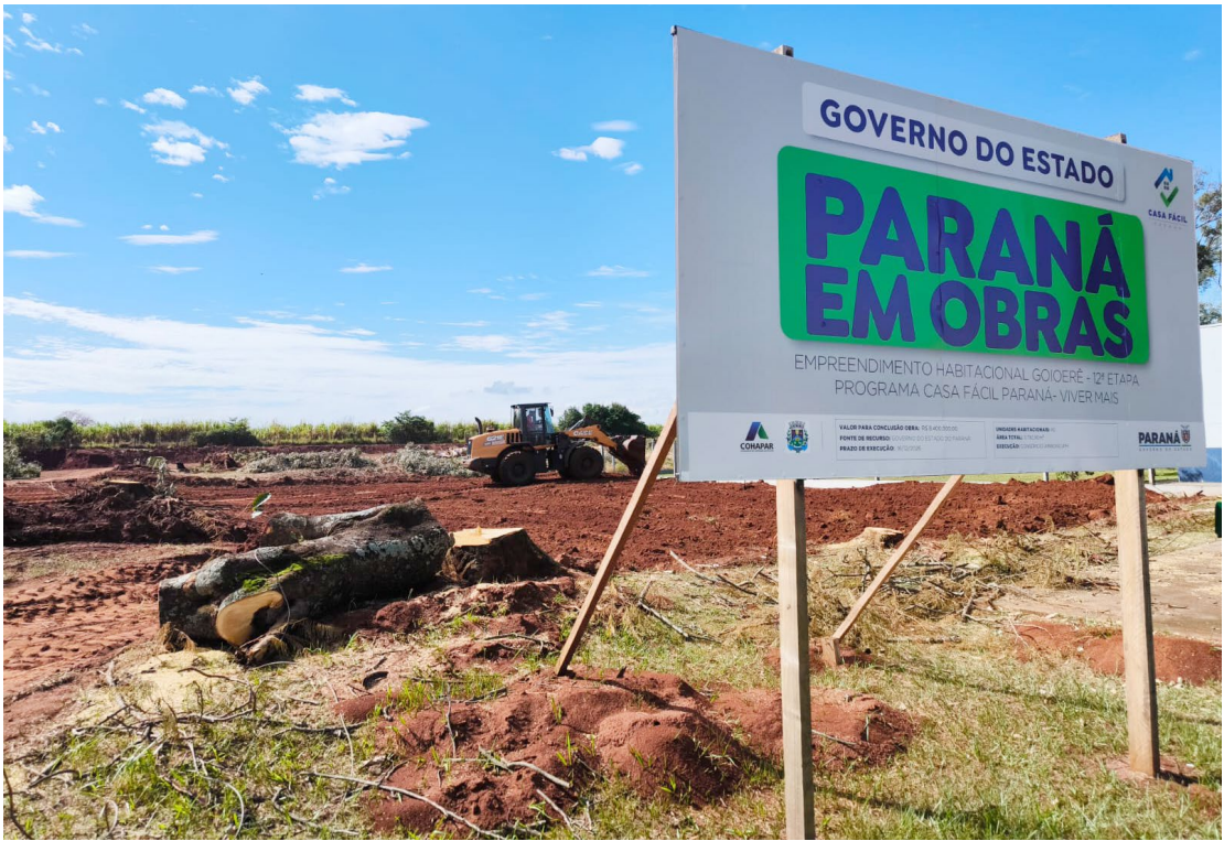
As obras para a construção do condomínio já foram iniciadas com os serviços de terraplenagem
