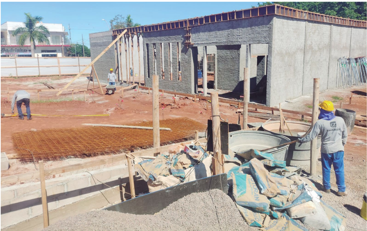
As obras estão bem adiantadas: Investimento de R$ 3,8 milhões
