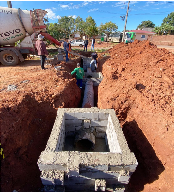
Entre as obras em andamento, destaque para serviços de galerias pluviais e pavimentação
