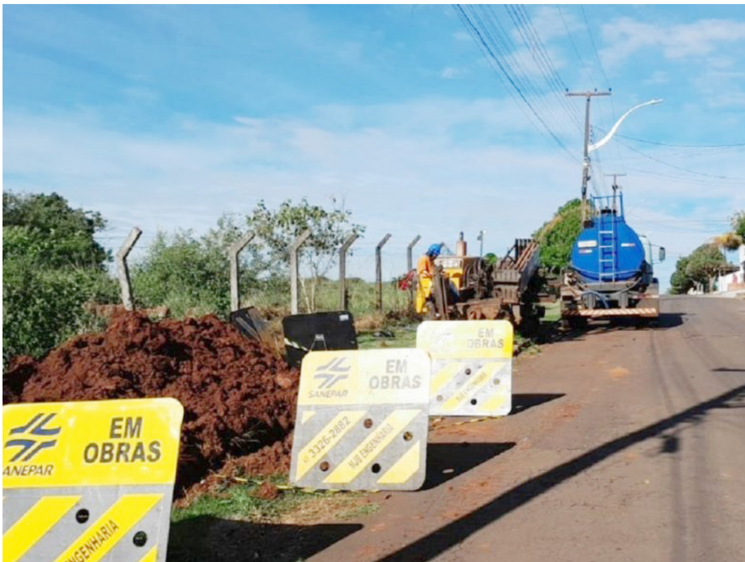
Os serviços estão sendo finalizados: 518 famílias serão atendidas
