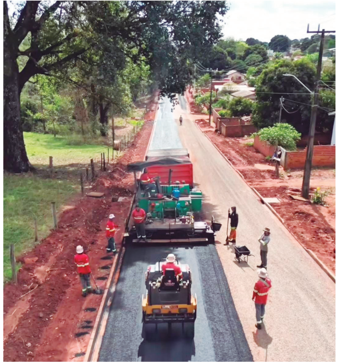
As obras foram realizadas em toda a extensão da avenida Antonio Oliva
