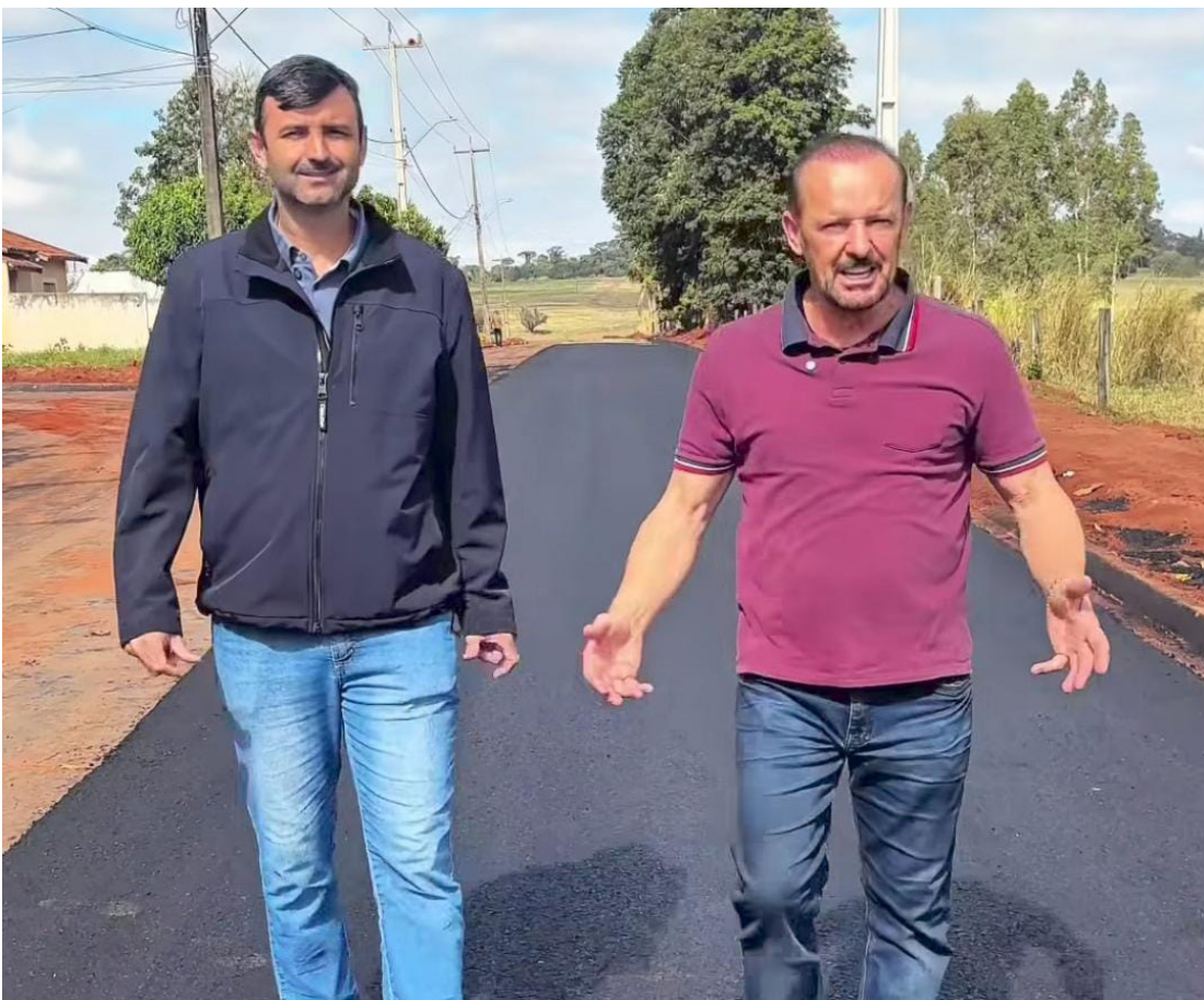
O prefeito Volpato e o vice Rafael: vistoria nas obras realizadas pela prefeitura
