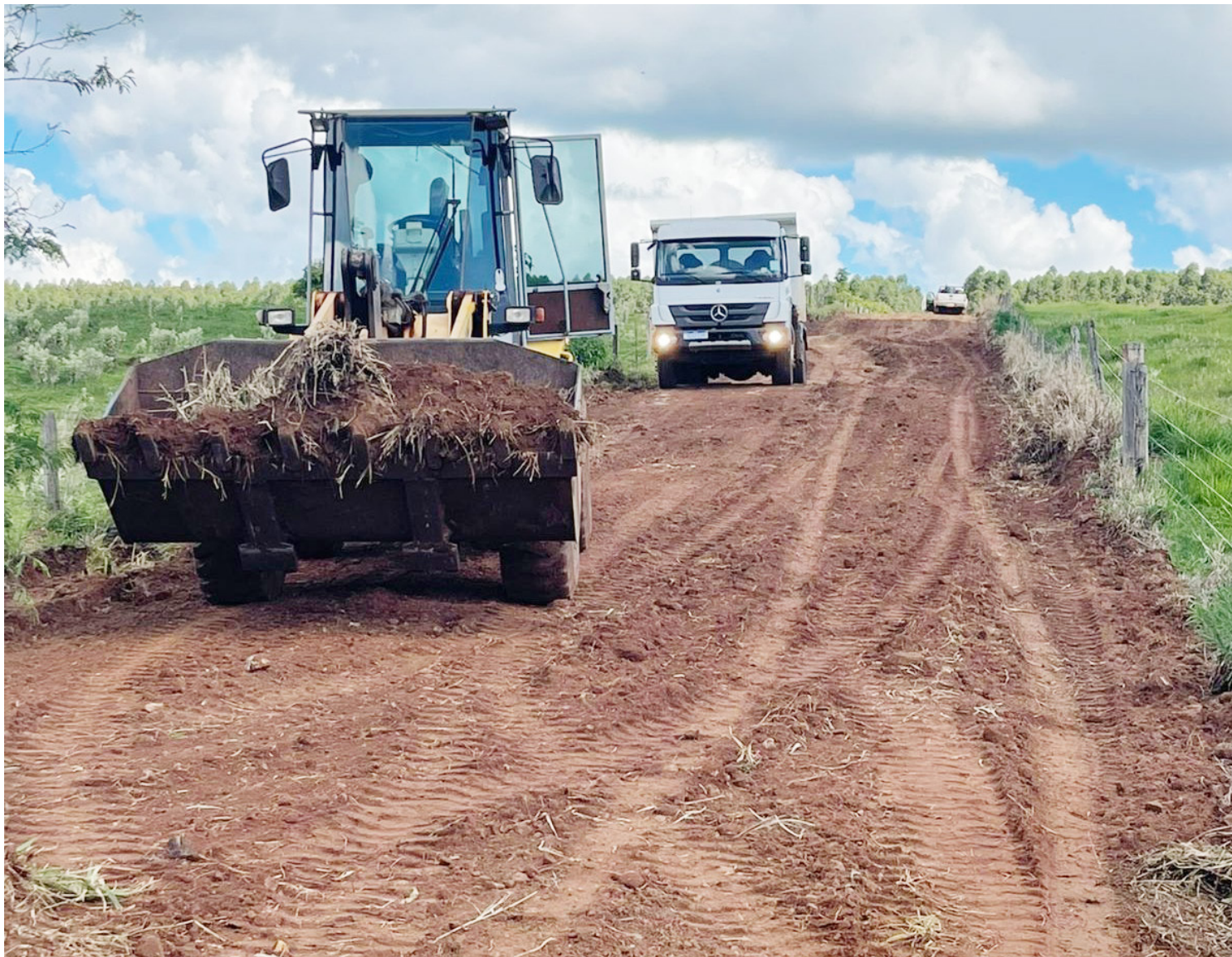
Os serviços executados incluíram a limpeza das margens da estrada e o cascalhamento de todo o trecho
