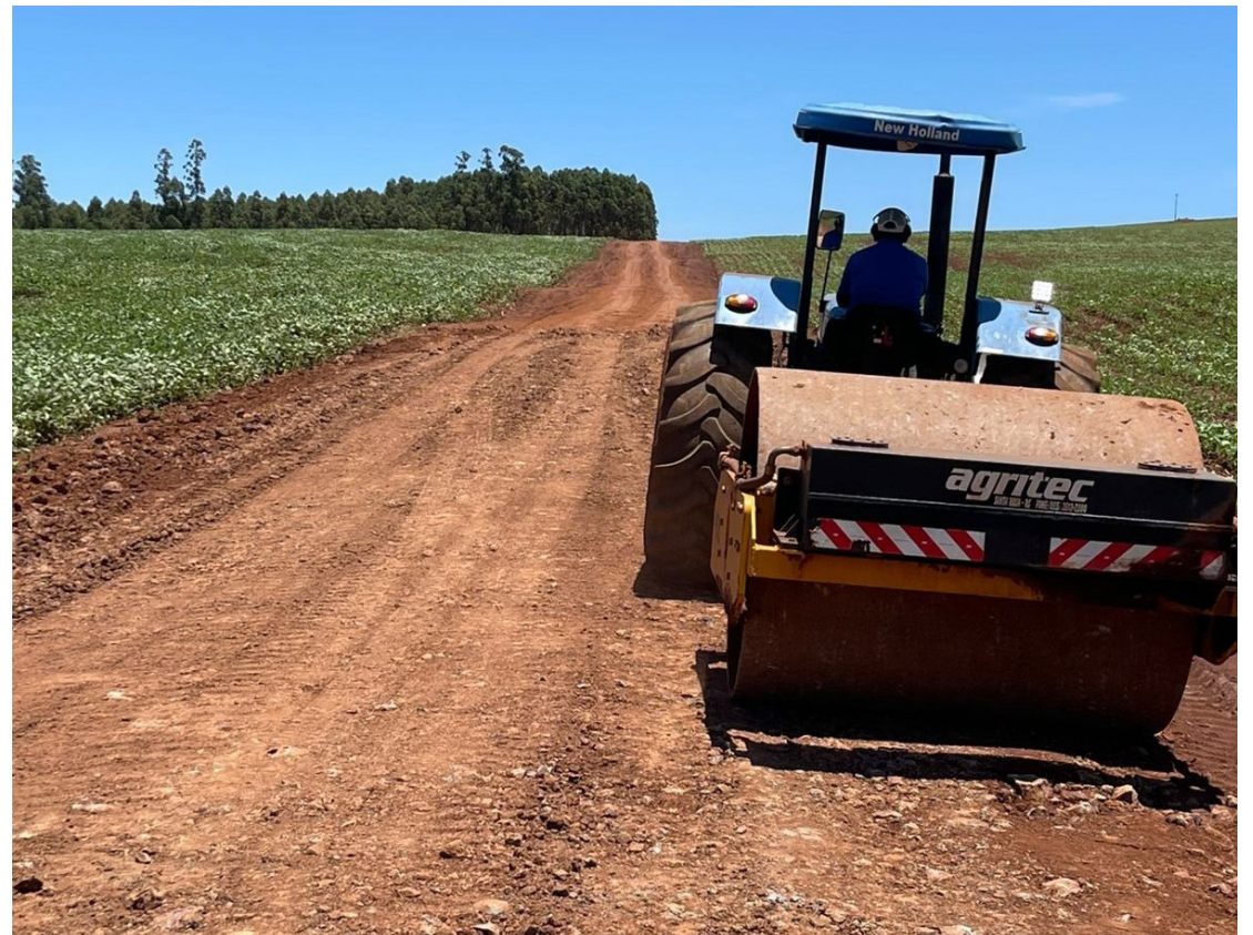
Os serviços foram iniciados nesta semana: readequação de estrada no interior do município
