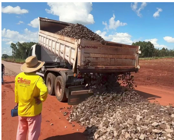
No total são 3,5 quilômetros de asfalto na estrada Santa Angelina: desenvolvimento
