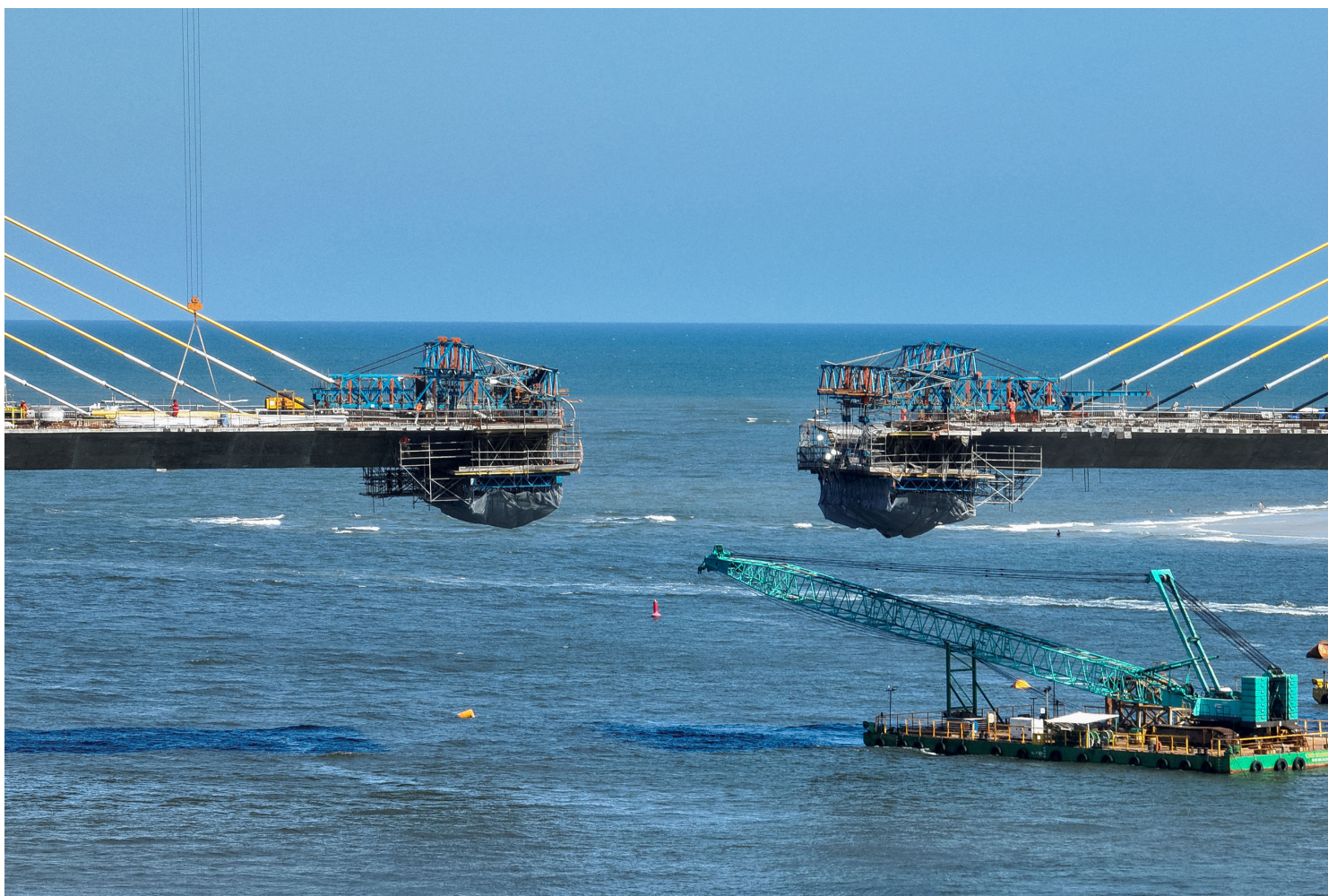
Com 320 metros de extensão, o trecho estaiado é o mais complexo e emblemático de toda a obra. Ele foi projetado para vencer o maior vão da ponte com 160 metros, garantindo segurança à navegação, com gabarito livre de 19 metros de altura por 90 metros de largura. A previsão é que o encontro seja realizado no final de fevereiro
