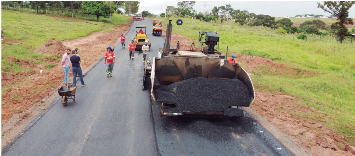
O primeiro trecho contemplado com asfalto é a estrada da AABB
