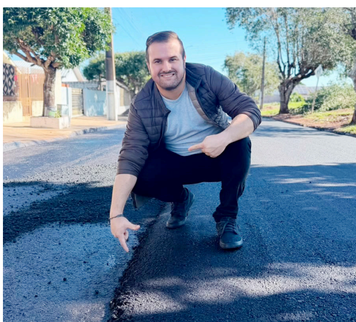
O prefeito Cássio Zanuto vistoria um dos pontos de rua que recebeu a pavimentação
