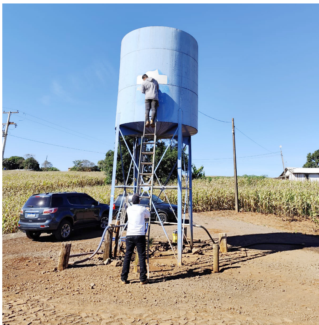
Os abastecedores serão revitalizados: ausência de manutenção pode comprometer qualidade da água
