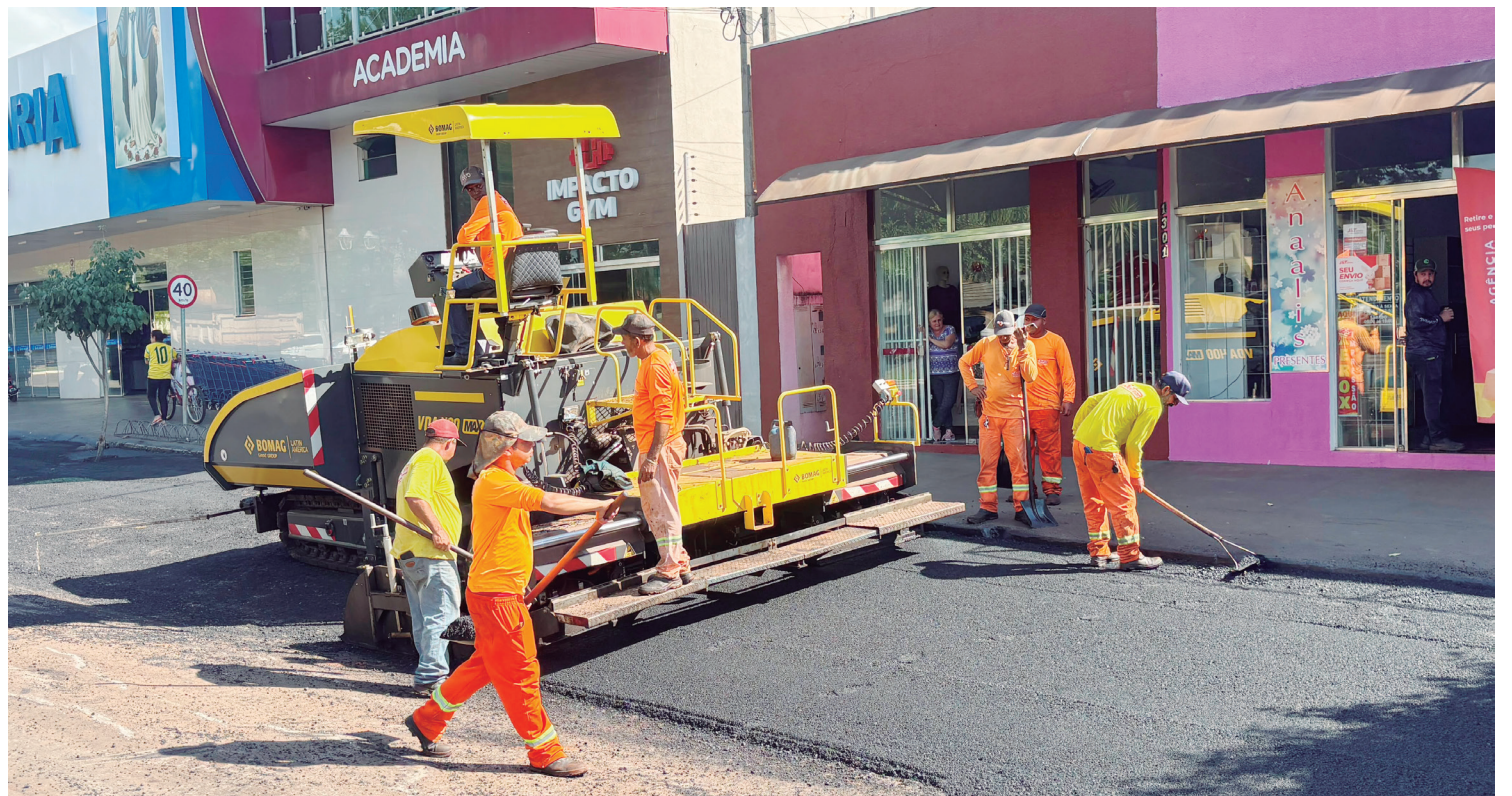
Moreira sales iniciou as obras de revitalização da Avenida João Theotônio, um dos principais acessos da cidade
