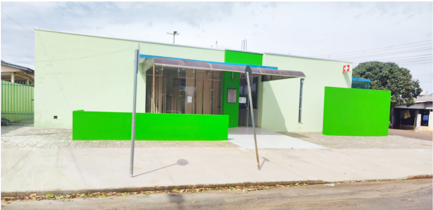
Os atendimentos serão feitos no prédio reformado da UBS
